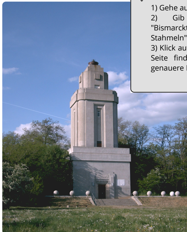
M8: Bismarckturm Lützschena-Stahmeln
