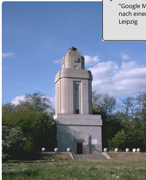
M7: Bismarckturm Lützschena-Stahmeln
