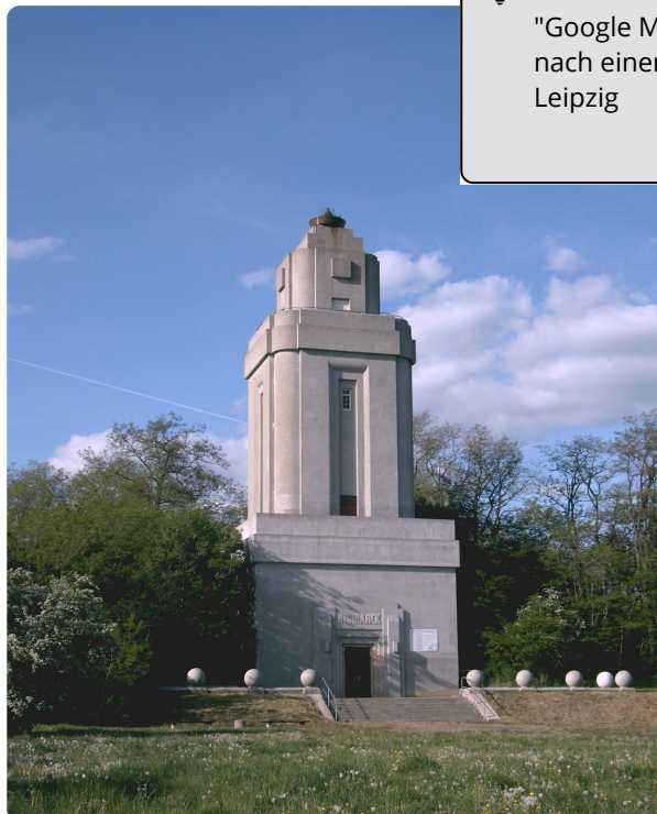
M7: Bismarckturm Lützschena-Stahmeln
