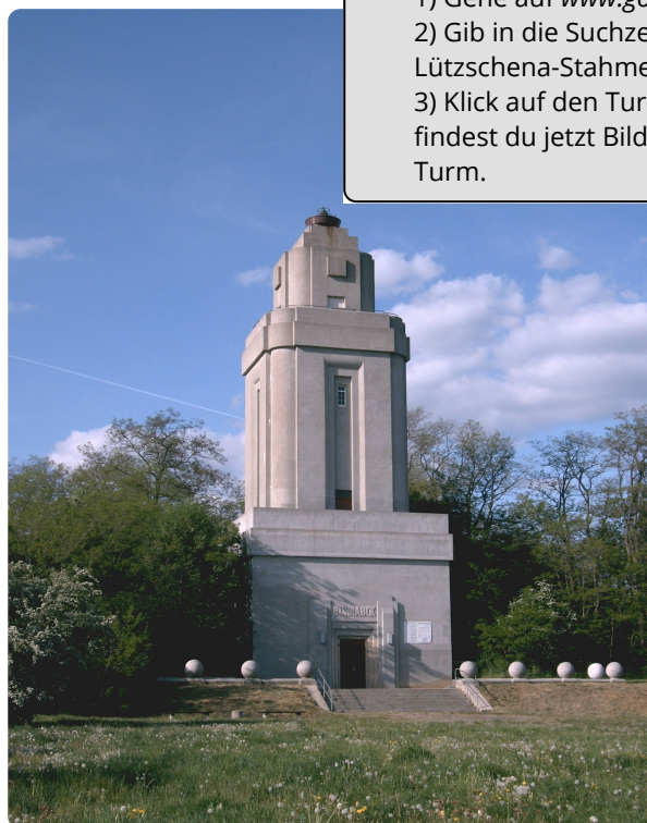
M6: Bismarckturm Lützschena-Stahmeln
