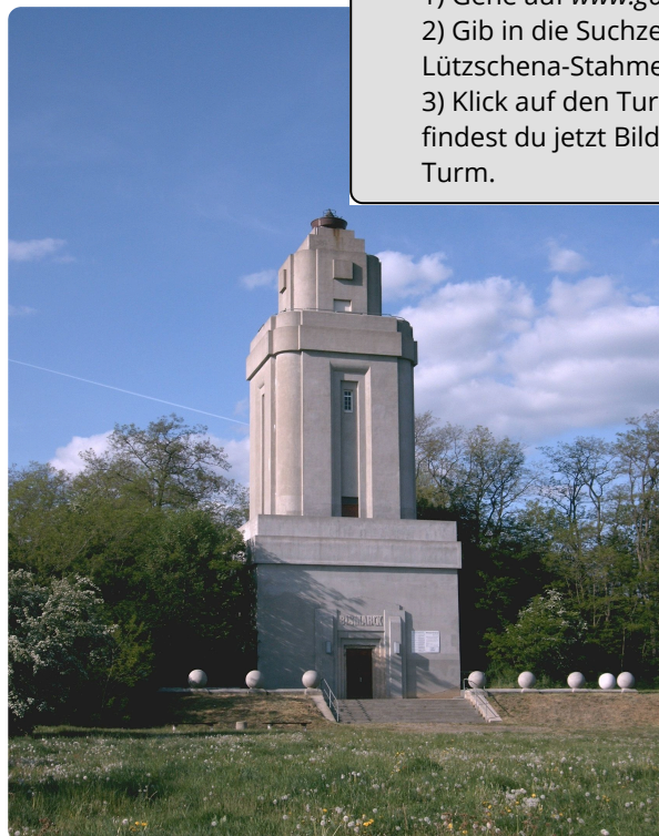
M6: Bismarckturm Lützschena-Stahmeln
