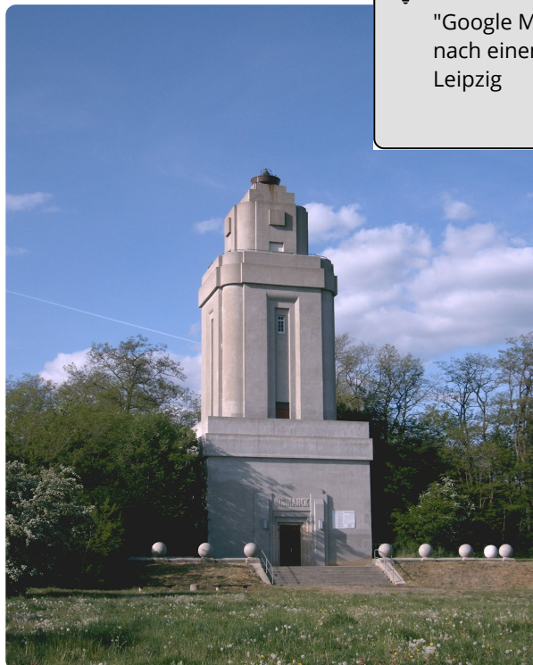
M6: Bismarckturm Lützschena-Stahmeln
