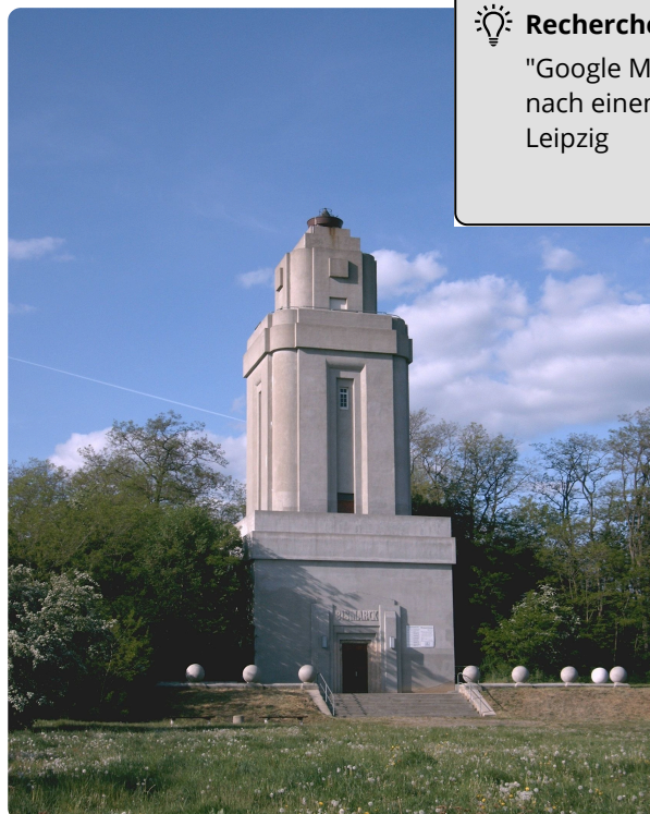
M6: Bismarckturm Lützschena-Stahmeln
