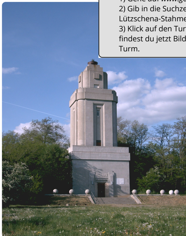
M6: Bismarckturm Lützschena-Stahmeln
