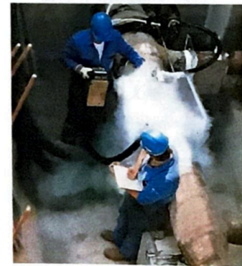
8 Stickstoff zum „Rohrfrost- en“
