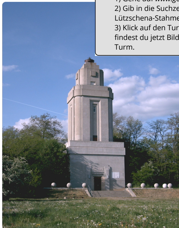
M6: Bismarckturm Lützschena-Stahmeln
