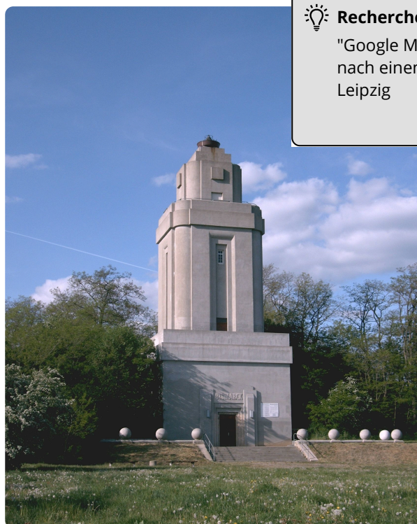
M6: Bismarckturm Lützschena-Stahmeln
